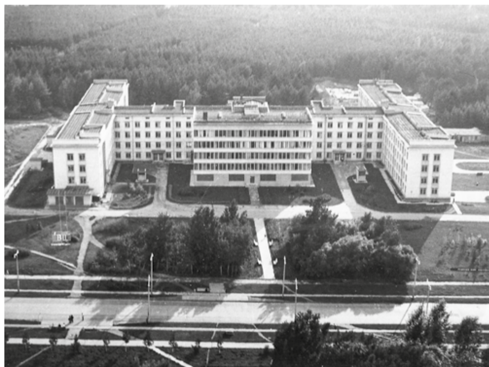
Здание Вычислительного центра СО АН СССР
