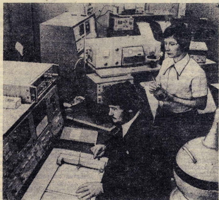
В лаборатории резонансных свойств магнитоупорядоченных веществ ведутся работы по поиску и исследованию магнитных материалов для техники СВЧ. На снимке: ведущий конструктор И. М. Столовичкий и аспирантка Л. С. Емельянова ведут измерения на ЭПР-спектрометре.
