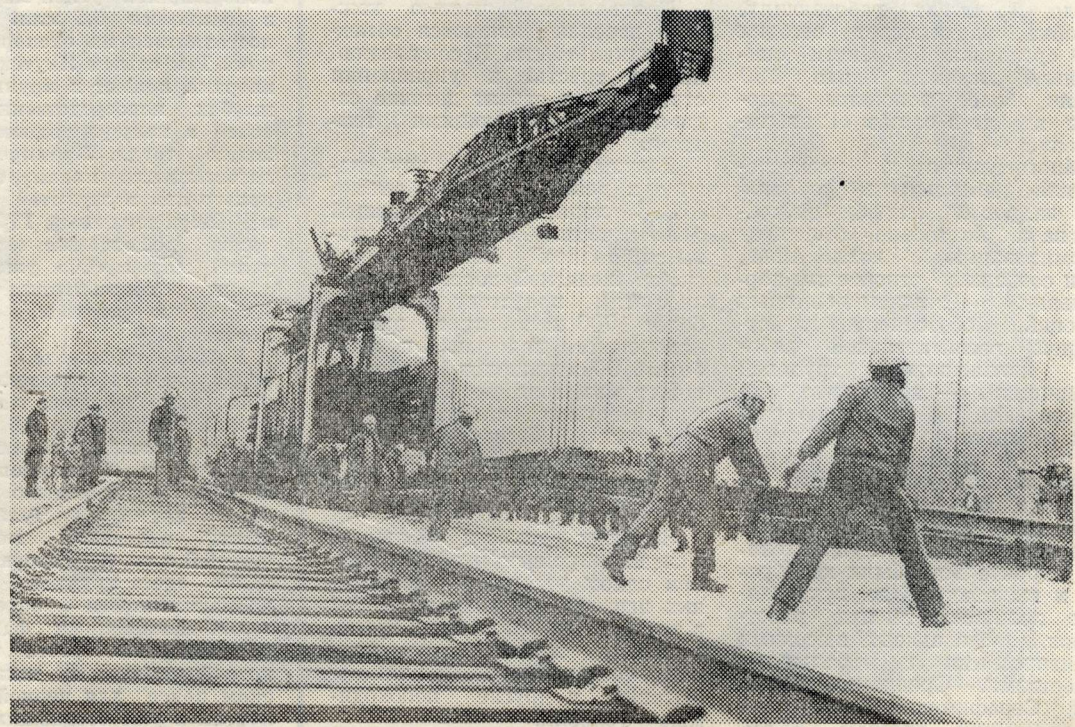
На снимке: укладка рельсов в районе станции Хани (Якутская АССР). Фото А. Пянова.
