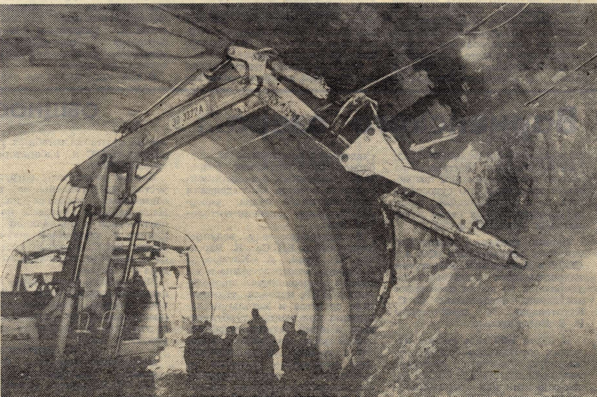
Испытание пневмомолота ПН-1700, созданного в Институте горного дела СО АН СССР. Тоннель «Витиня» (Народная Республика Болгария).
