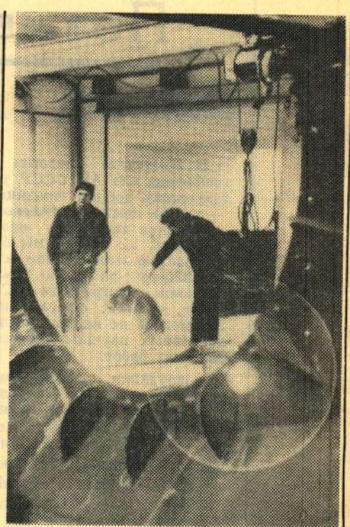
© В подземном этаже Института сильноточной электроники СО АН СССР. На снимке: идет сборка корпуса мощного ускорителя плотных электронных пучков.
