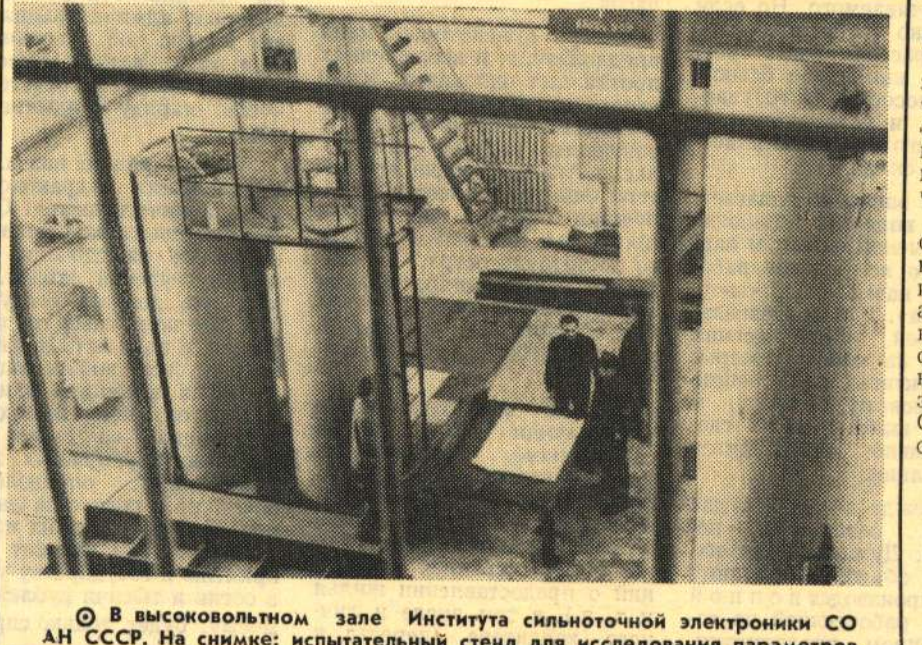
© В высокоточном зале Института сильноточной электроники СО АН СССР. На снимке: испытательный стенд для исследования параметров мощных наносекундных коммутаторов.
