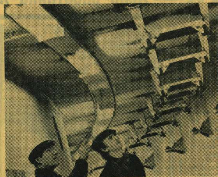
Институт ядерной физики СО АН СССР. Идет монтаж системы подвески электромагнитов накопителя ВАПП-4. Фото В. Новикова.
