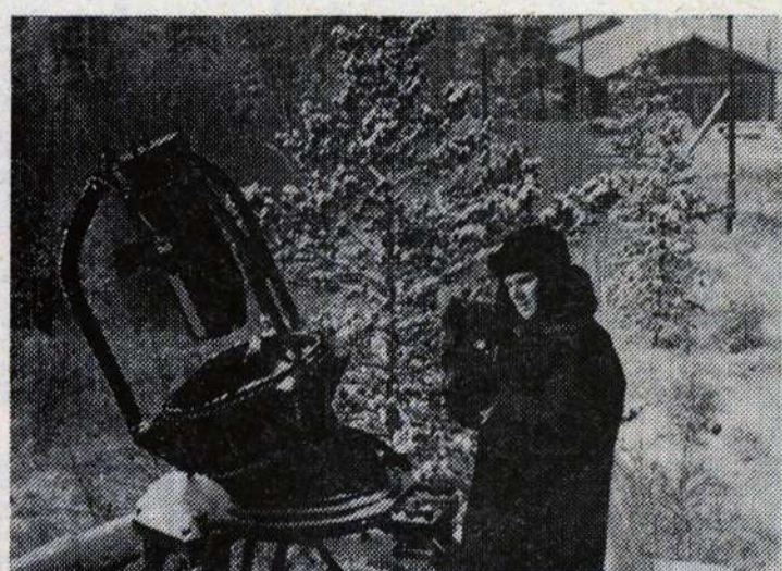
ИНСТИТУТ КОСМОФИЗИЧЕСКИХ ИССЛЕДОВАНИЙ И АЭРОНОМИИ. Инженер лаборатории полярных сияний В. Петров готовит автоматическую фотокамеру С-180 к съемке полярных сияний.
